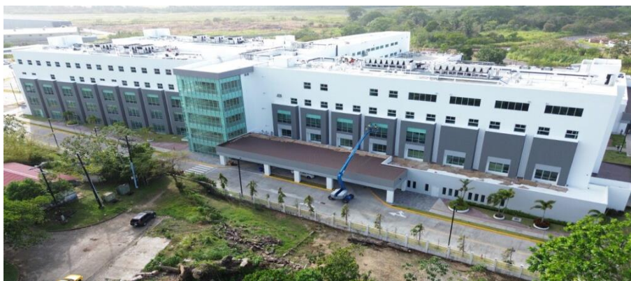
Sector Salud Ministerio de Salud “Construcción del Nuevo Hospital de Colón”
