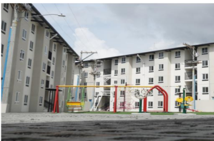
Sector Vivienda Ministerio de Vivienda y Ordenamiento Territorial "Construcción Edificio Miguel Mickey Sierra"
