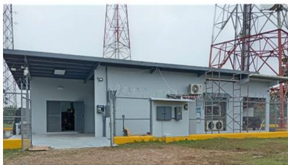
Casetas de sitios de Transmisión Santa Rita, Colón
