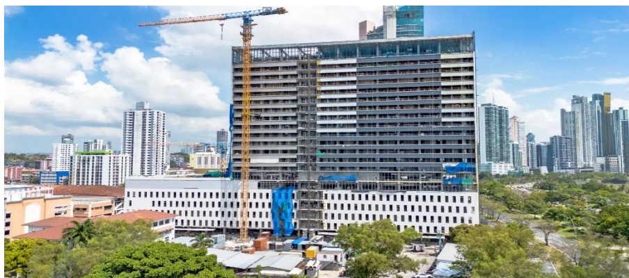
Sector Salud Ministerio de Salud “Construcción del Nuevo Hospital del Niño”
