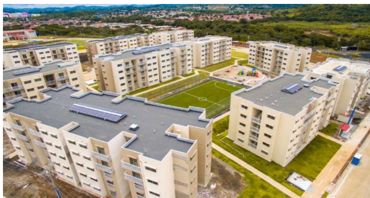
Sector Vivienda Ministerio de Vivienda y Ordenamiento Territorial “Construcción Complejo Habitacional Ciudad de Esperanza”
