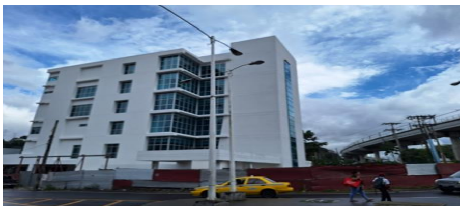
Sector Salud Ministerio de Salud “Construcción Policentro San Isidro”
