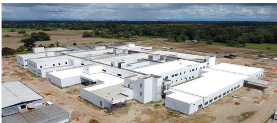
Sector Salud Ministerio de Salud “Construcción del Nuevo Hospital de Darién”
