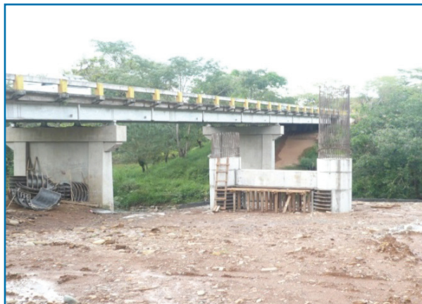
Rehabilitación y Ensanche Tramo II Vigüí - San Félix - Construcción de pilotes, Puente Quebrada La Onda.
