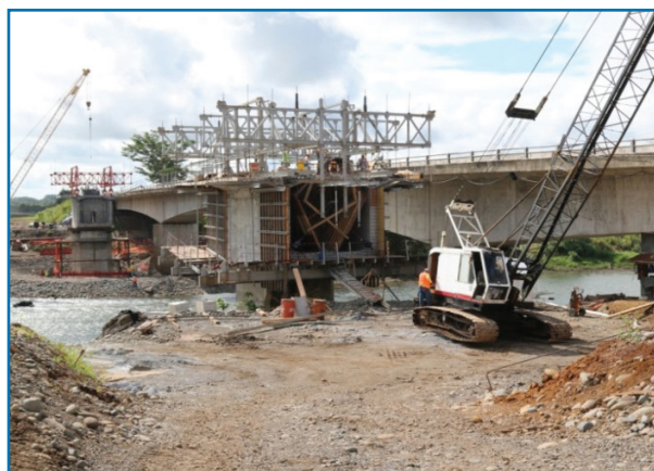
Rehabilitación y Ensanche Tramo V La Pita - David - Construcciones en el Puente del Río Chiriquí.
