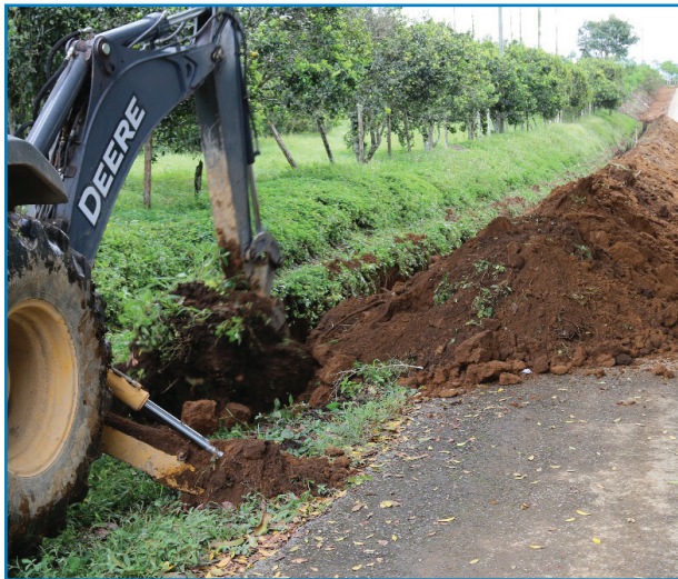
Instalación del Sistema e Conducción de Agua (Sistema de Riego Río Sereno).
