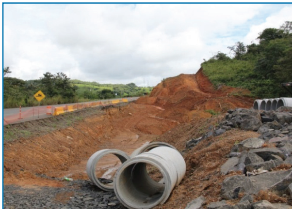
Rehabilitación y Ensanche Tramo I Santiago - Vigüí - Remoción de Terreno para la ubicación de cunetas.
