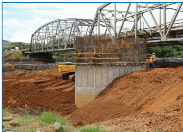
Rehabilitación y Ensanche Tramo IV San Juan - La Pita - Construcción de Pilotes Puente Río Fonseca.
