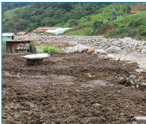
Punto de Capacitación de Agua del Sistema de Riego Bambito.
