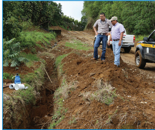
Instalación de Válvulas de Drenaje (Sistema de Riego Río Sereno).
