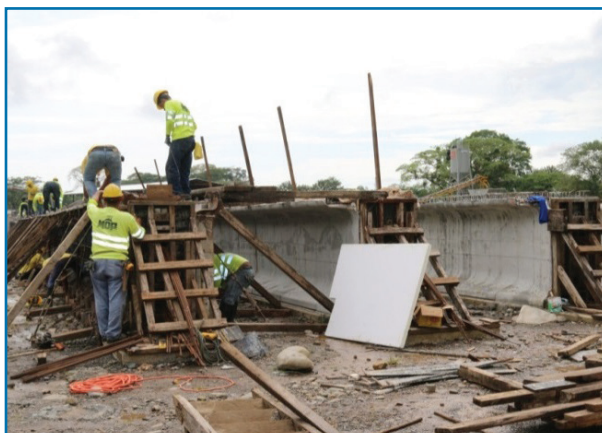
Rehabilitación y Ensanche Tramo III San Félix - San Juan - Construcción de Vigas, Puente Río Juay.
